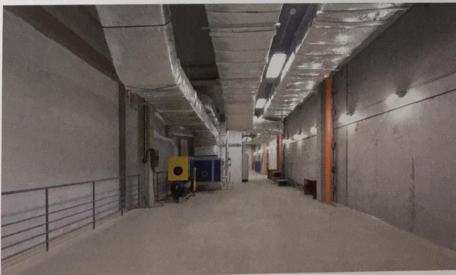
Guarda-corpo de proteção para o fosso (de 60 cm) separa edifício de “utilidades” do corpo principal dos laboratórios. O bloco abriga equipamentos, como a casa de máquinas de ar-condicionado (fancoil) e dutos de insuflamento
