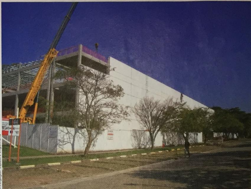
Grande empena fechada com painéis pré-fabricados de concreto foi uma das soluções para minimizar entrada de calor no edifício
