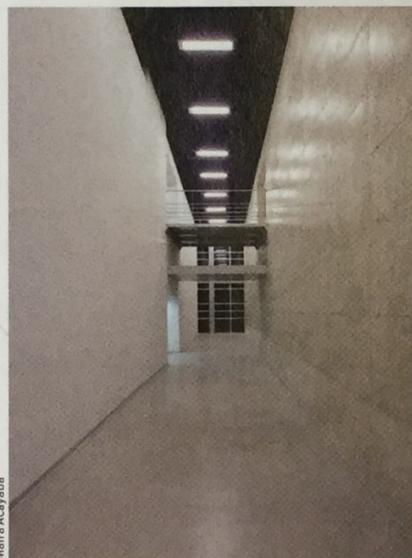
Ligação entre blocos é feita por passarelas metálicas, que também têm a função de evitar transmissão de eventuais vibrações aos equipamentos dos laboratórios
