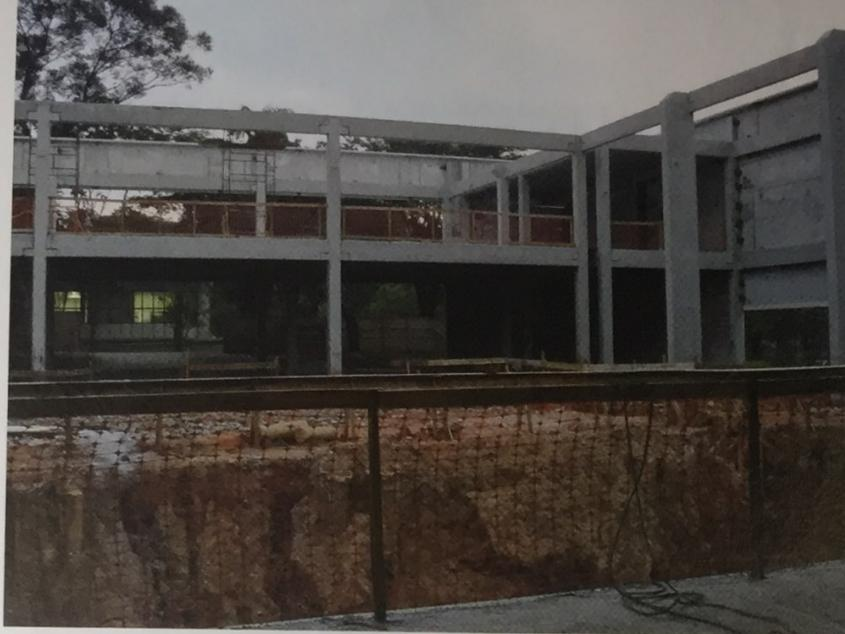
Estrutura de concreto pré-fabricada conforma edificação que abriga três grandes blocos no seu interior
